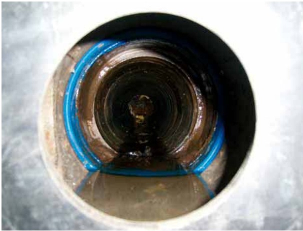
Bohrkanal mit Abdichtung hinter der Schachtwand.
