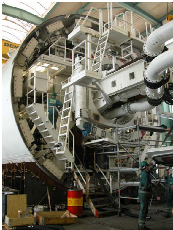
Tunnelvortrieb mit Know how und modernster Technik
