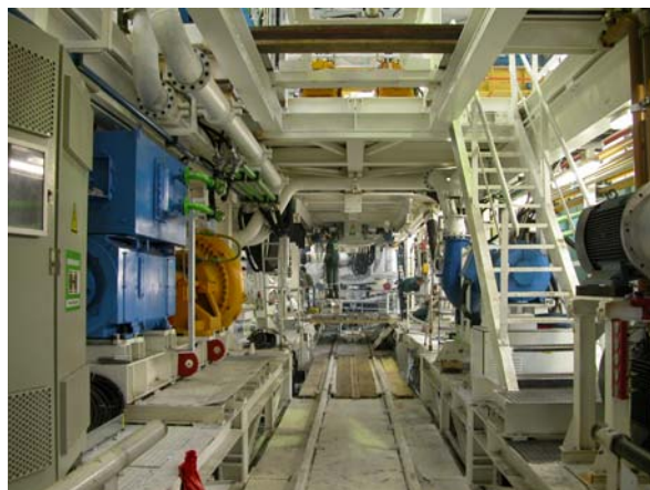
Blick vom Nachläufer 2 zur Tunnelbohrmaschine
